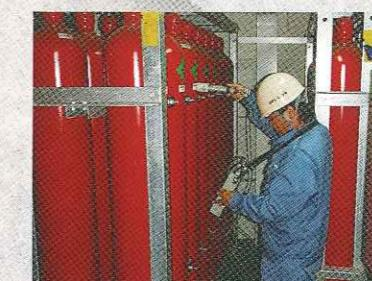
船舶に積載されている消火剤CO<sub>2</sub>のボンベ内充填状況（液レベル）を現場で測定します。
