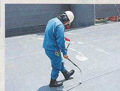
タンクトップ溶接線の気密検査
